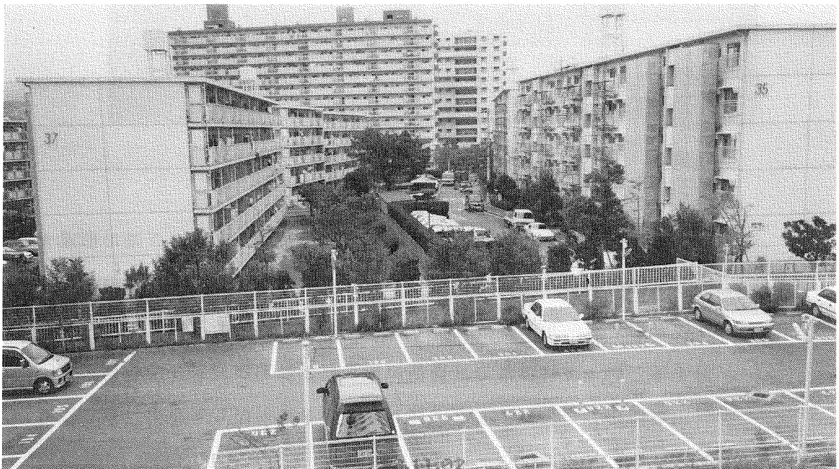
写真6 事件当時、この駐車場は、ほとんど整備されておらず、フェンスの設置された辺りは、視界を切斷する雑草が生い茂っていた。
