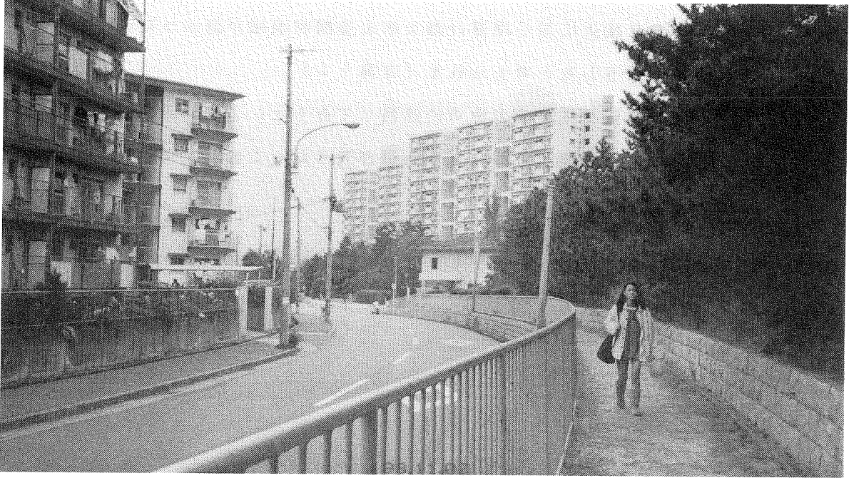
写真12 中央部が盛り上がりながら、緩やかにカーブする事件現場の歩道。
